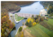
Pont-et-Massène Dam @VNF
