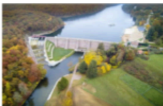
Barrage de Pont-et-Massène @VNF
